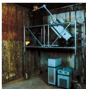
Abb. 5 Großflächige Reinigung der Bohlenstube, Pirna
